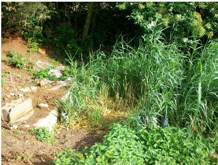
Lits avec absence d'entretien (colmatage)
