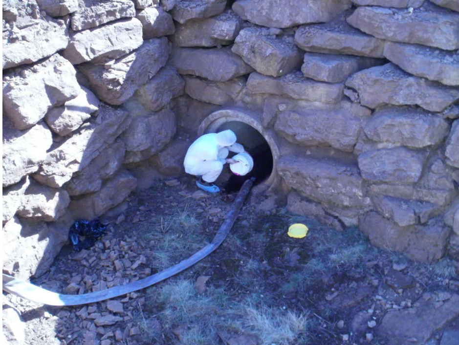
Photo 6 - injection de 3 kg de sulforhodamine B en sortie du bassin du tunnel technique
