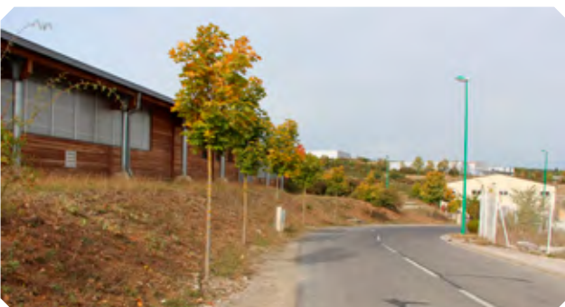
En l'absence de clôture, la parcelle du haut valorise l'espace public (zone d'activité Millau Viaduc).
