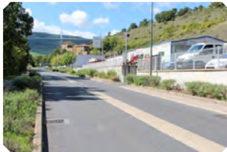
Traitement végétal du pied du mur de soutènement (Creissels).
