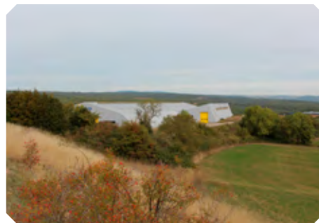
Raccordement du talus de la plateforme au terrain naturel en s'appuyant sur la végétation existante (zone d'activité Millau Viaduc).
