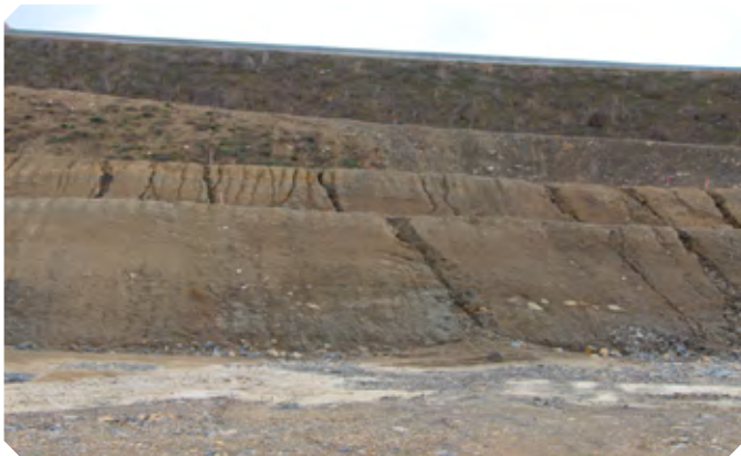
Talus traité avec plusieurs paliers ou risbermes permettant de le stabiliser et de le végétaliser à terme (ZA Millau ouest).
