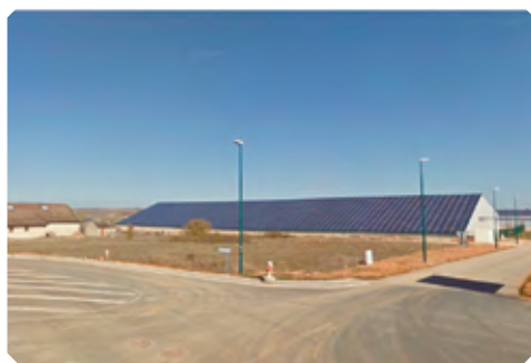
Toiture photovoltaïque de l'imprimerie du Progrès à la Cavalerie
