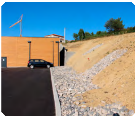
Au premier plan le talus a un profil technique qui sera difficile à entretenir. Au fond, à l'arrière du bâtiment, un mur de soutènement permet de maintenir le talus (zone d'activité Cap du Cres).
