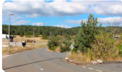
Lampadaires avec poteau bois qui reprend la typologie des bordures, des parements (zone d'activité La Tieule- 48).
