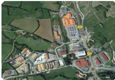
Vue aérienne de la ZA de Creissels qui totalise des surfaces de toiture importante.
