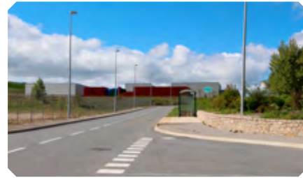
Ici l'abri bus n'est pas posé au bord de la route. Le mur de soutènement et son retour permet de le raccrocher (zone d'activité de Lauras).
