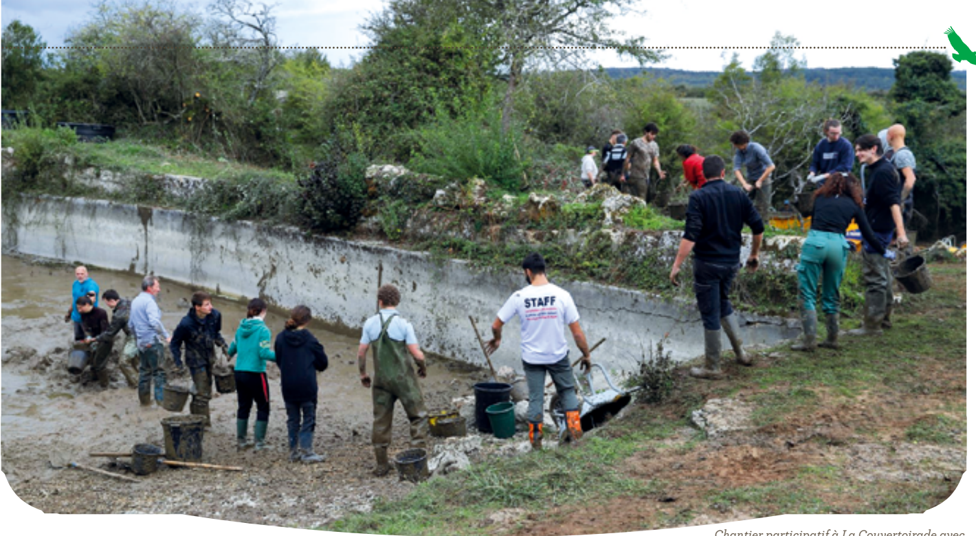
Chantier participatif à La Couvertoirade avec les élèves du BTS GPRI à la MFR de Valrance
