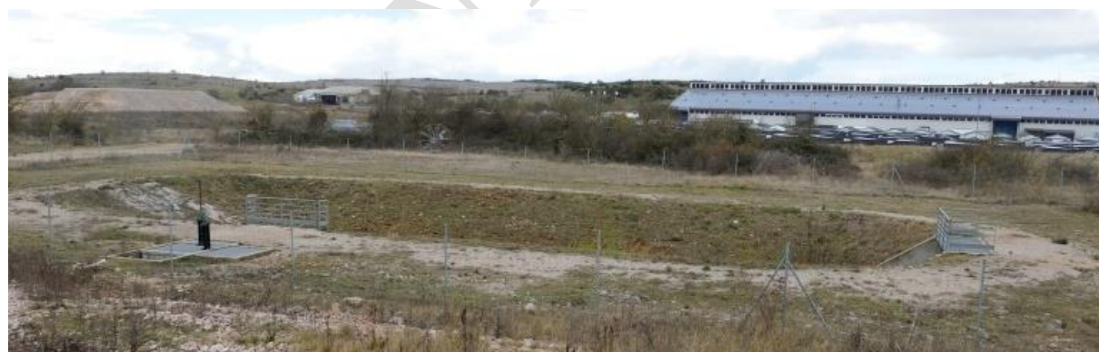
Figure 25 : Bassin de rétention de la ZAC Millau-Larzac
