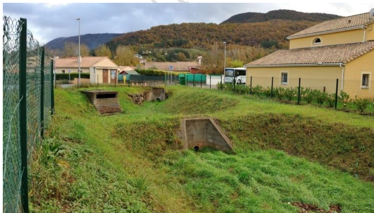
Figure 22 : Bassin de rétention du lotissement "les Méjaliès"
