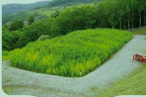
Épuration des eaux usées à Castelnau-Pégayrols (filtre à sable planté de roseaux)
